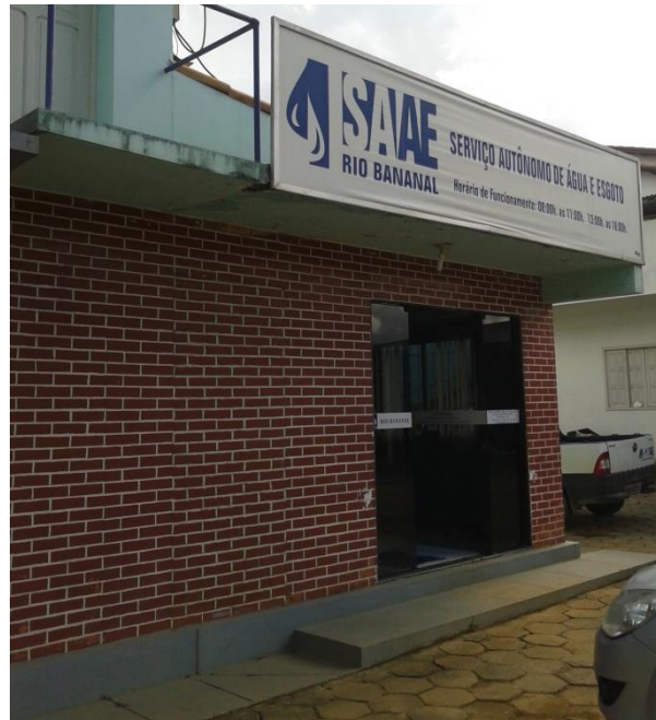
Figura 3 - Estação de Tratamento de Água
