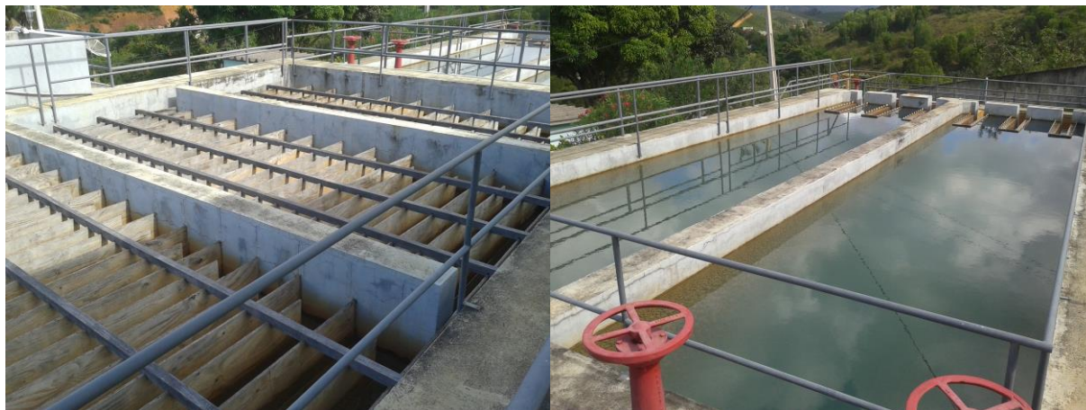
Figura 21 - Ampliação da ETA
