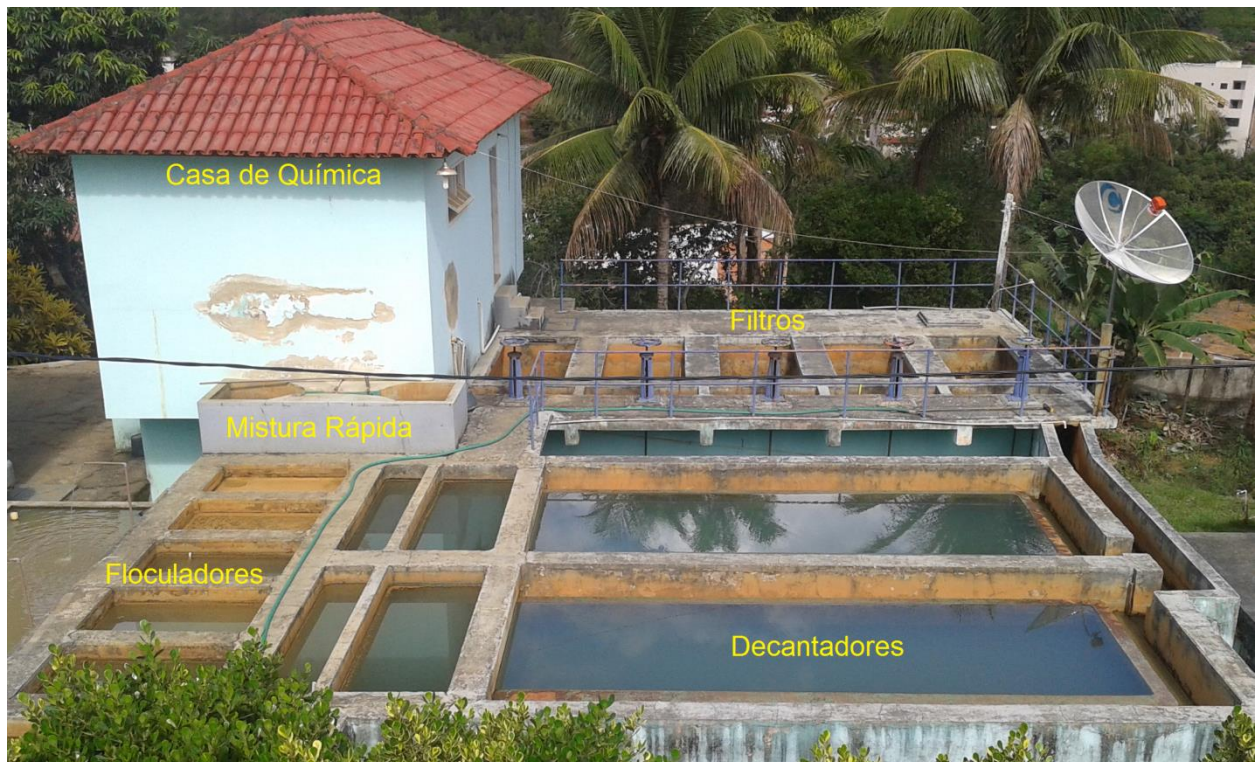
Figura 5 - Processos da ETA
