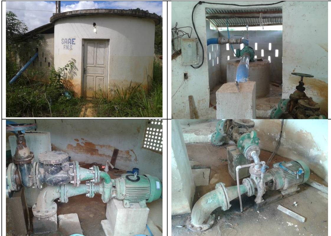
Figura 2 - Estação Elevatória de água bruta da captação do rio Iri-Timirim
