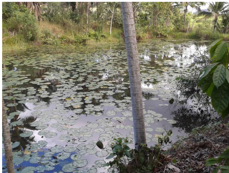
Figura 12 - Lagoa onde fica o efluente final após o tanque de filtração
