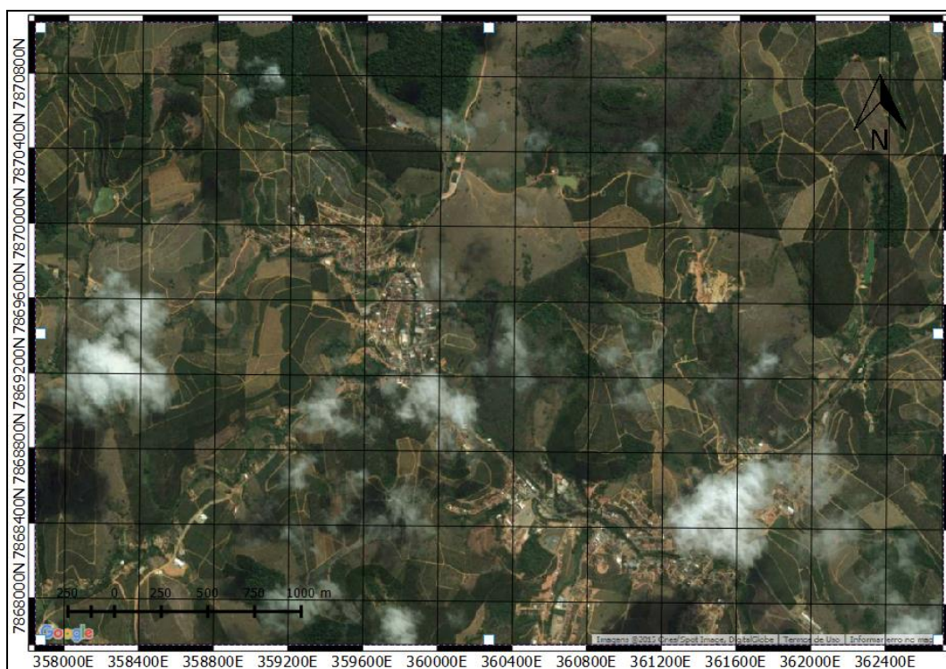
Figura 46 - Vista Superior da Sede municipal de Rio Bananal
