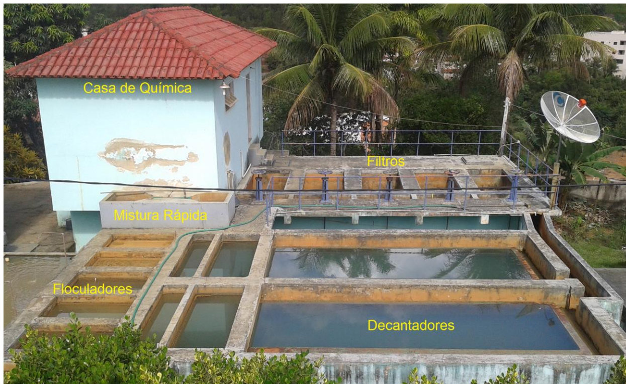
Figura 20 - Processos da ETA
