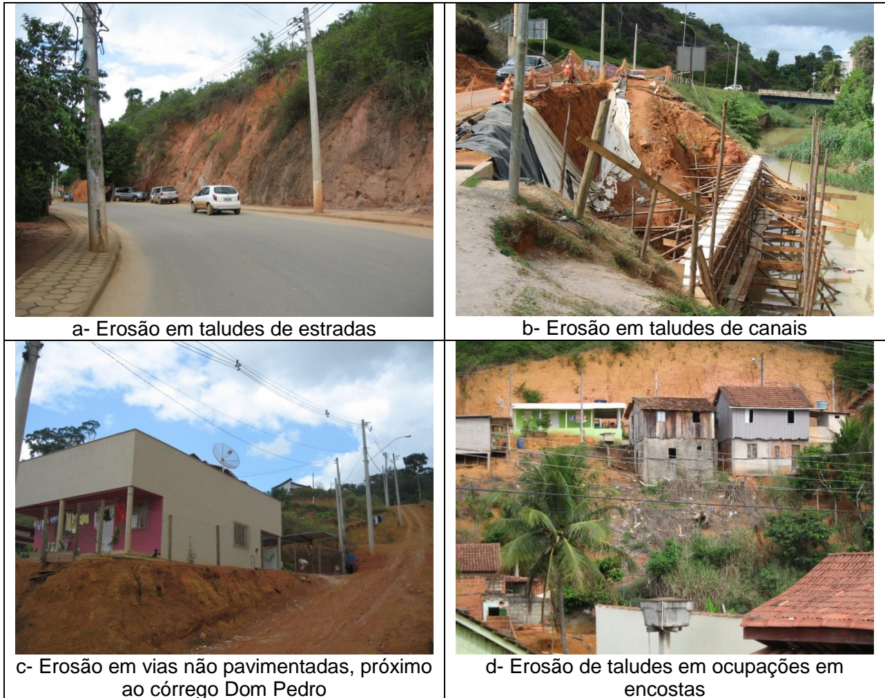
Figura 84 - Erosões na sede do município de Rio Bananal
