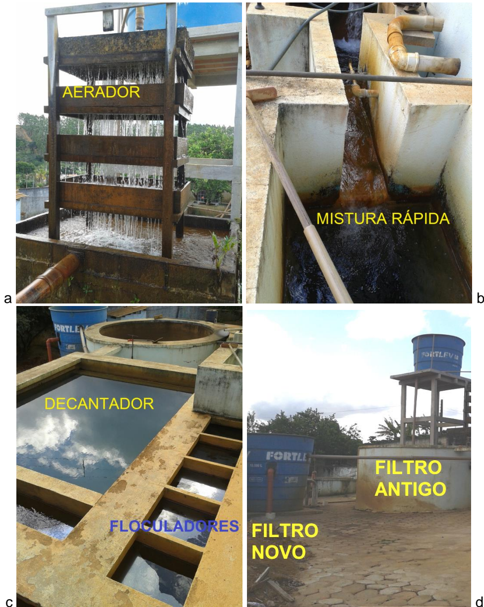
Figura 10 - Estação de Tratamento de Água de São Jorge de Tiradentes
