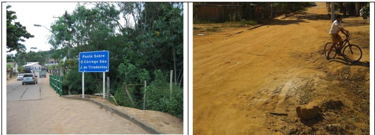
Figura 48 - Aspectos das vias sem microdrenagem.
