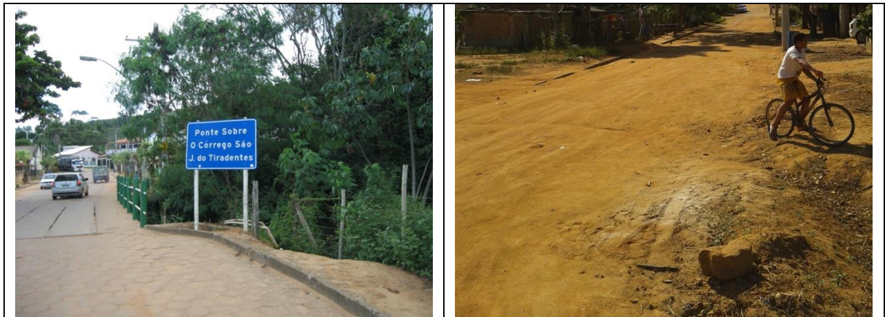
Figura 53 - Aspectos das vias sem microdrenagem.
