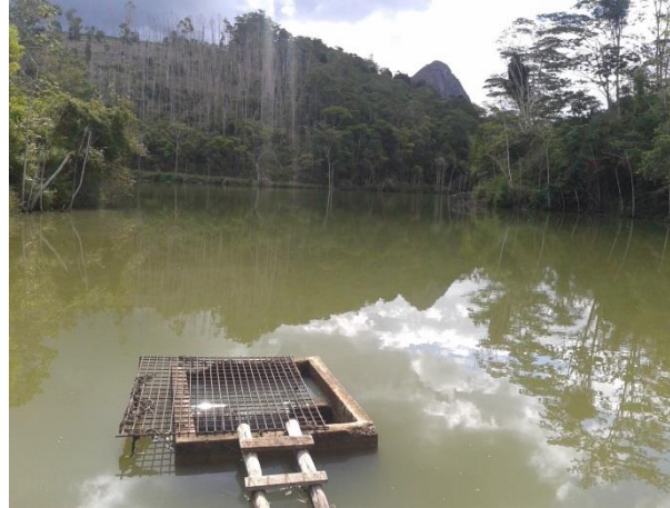
Figura 4 - Ponto de captação do córrego Farroupilha
