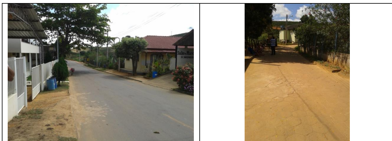
Figura 56 - Aspectos das vias e falta de infraestrutura de microdrenagem.
