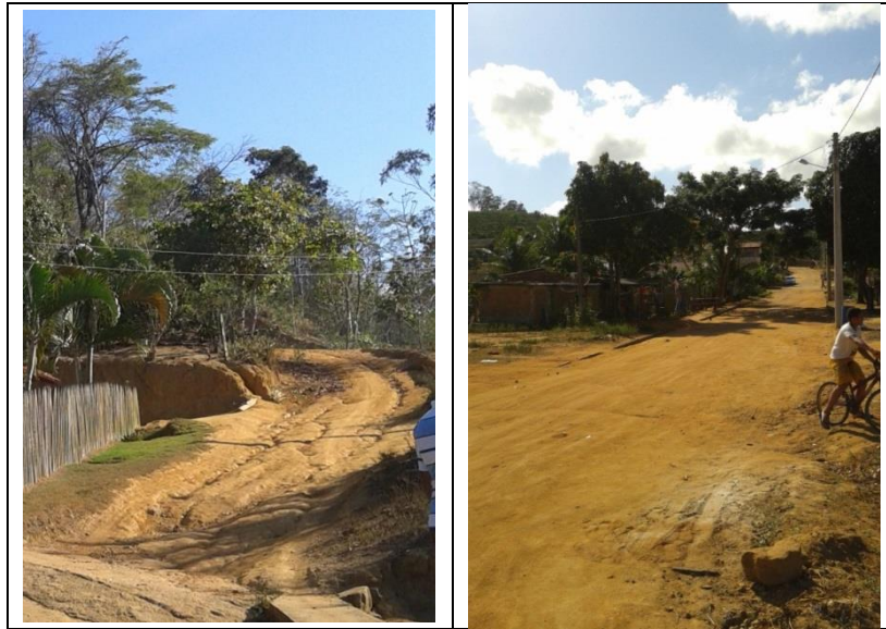
Figura 80 - Erosão das vias não pavimentadas
