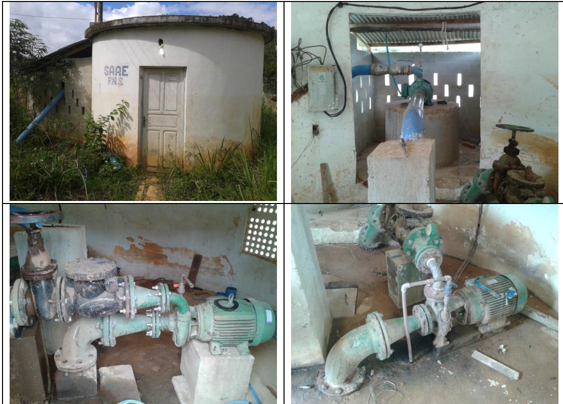
Figura 17 - Estação Elevatória de Água Bruta da Captação do rio Iri-Timirim
