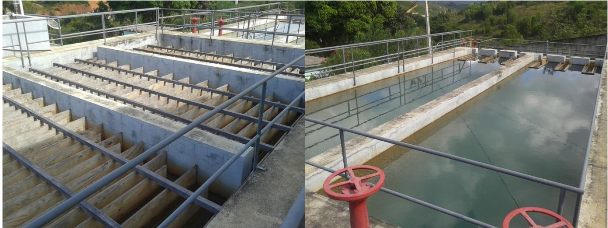
Figura 6 - Ampliação da ETA
