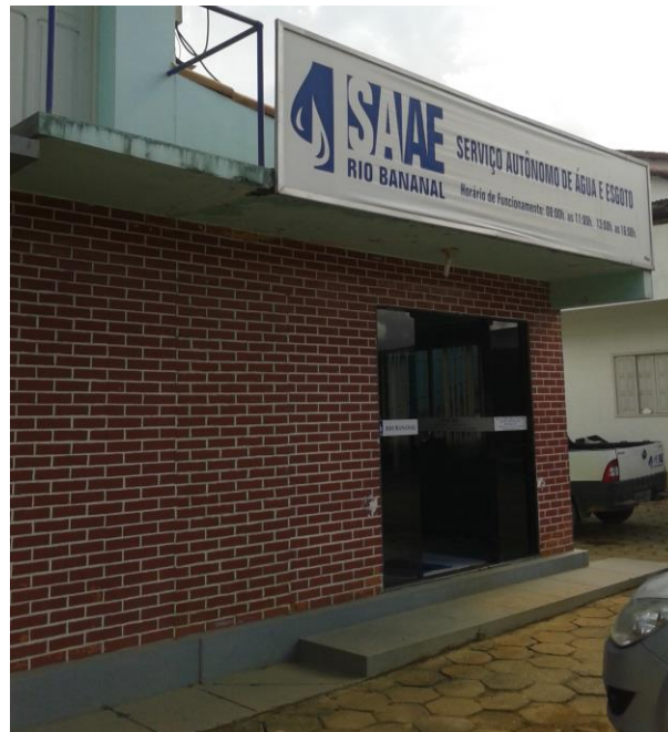
Figura 18 - Estação de Tratamento de Água
